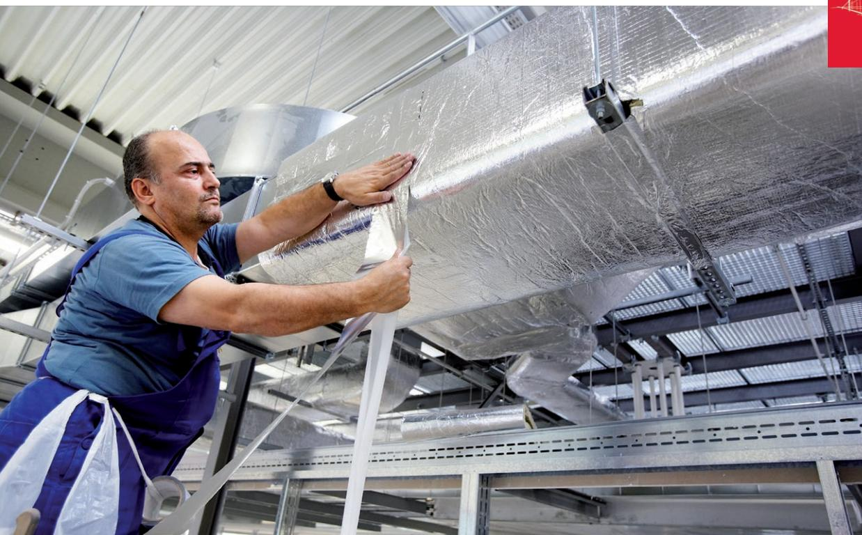
Aluminiumklebeband mit einem sehr klebstarken, stark vernetzten Polyacrylat-Haftkleber. Es ist sehr hitzebeständig und hat eine hohe Scherfestigkeit. Alufix ist optimiert für die Verklebung von Dämmstoff-Stoßstellen, die hohen Temperaturbelastungen standhalten müssen. Alufix ist alterungsbeständig, die Festigkeit der Verklebung nimmt im Laufe der Zeit zu.
